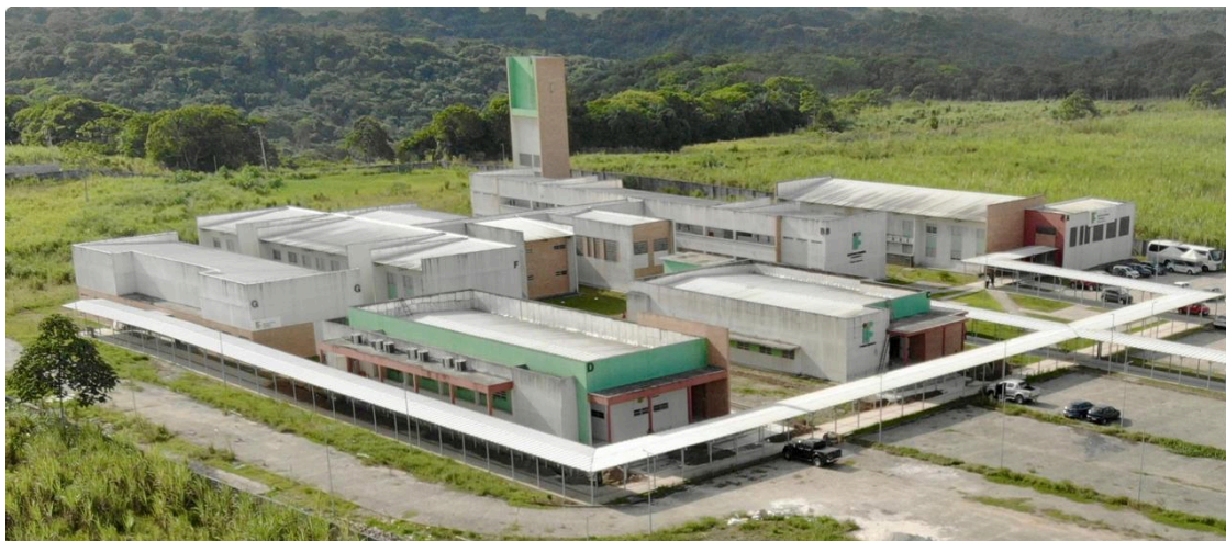
Imagem 2 - Estrutura física do IFPE Campus Igarassu contendo um bloco de salas de aula, dois blocos de laboratórios, biblioteca e auditório.
