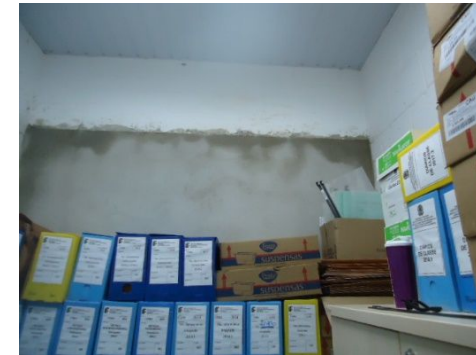
Figura 16: Infiltração
