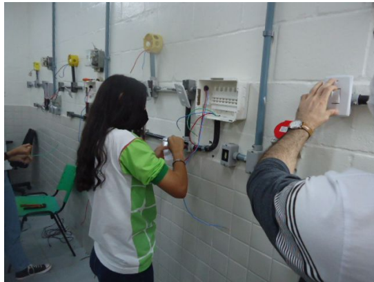
Figura 59: Práticas de Instalações Elétricas
