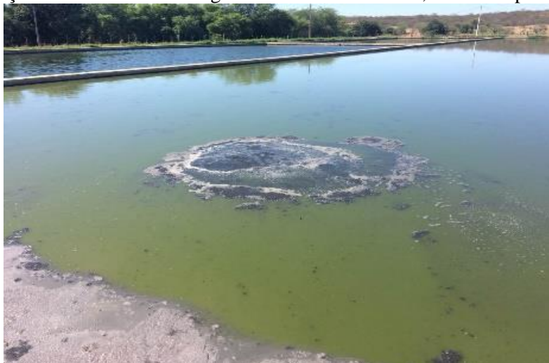
Figura 1 - Estação de Tratamento de Esgoto aeróbica da CAERN, no município de Florânia/RN
