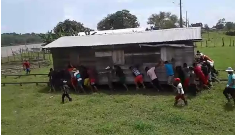
Figura VIII: Casa sendo empurrada sobre os trilhos, em uma comunidade do Arquipélago do Januário.
