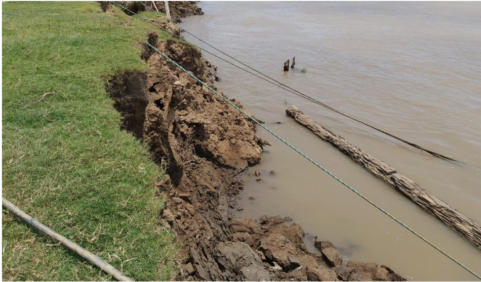
Figura VII: Terra caídas as margens do rio Madeira.
