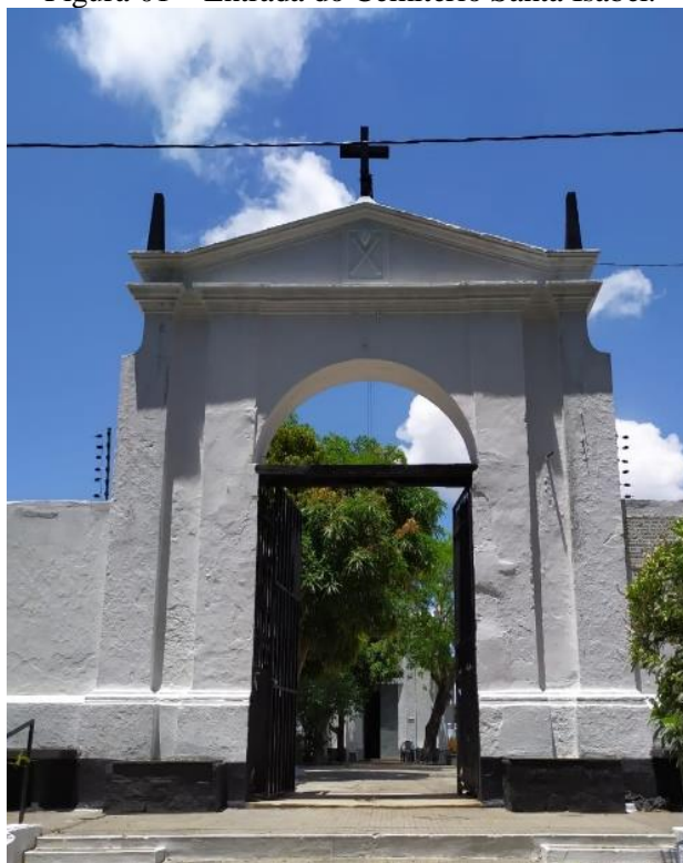
Figura 01 – Entrada do Cemitério Santa Isabel.
