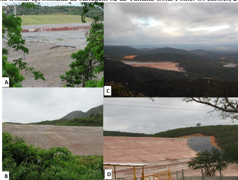
Figura 4 – a/b) vista panorâmica da barragem 01 desativada; c) Vista panorâmica da barragem 02 ativa; d) vista frontal aproximada da barragem 02 da Yamana Gold. Fonte: Os autores, 2020.
