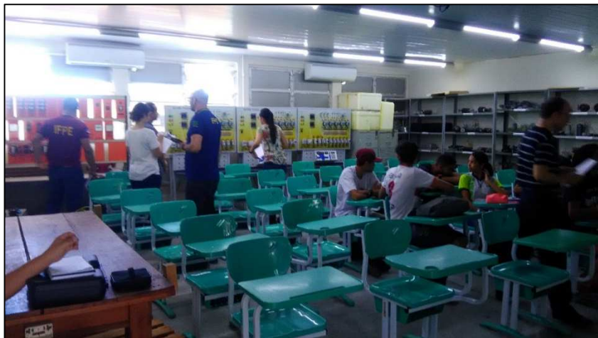
Foto 1: Sala E10 – Laboratório de Medidas e Máquinas Elétricas.
