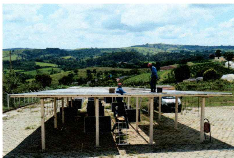
Figura 02 – Instalação de células fotovoltaicas no estacionamento do IFSULDEMINAS – campus Muzambinho
