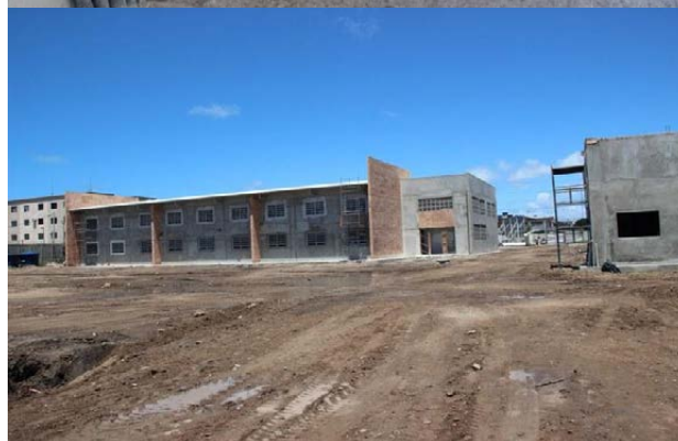
Construção da sede definitiva do Campus Paulista. Fonte: Portal IFPE
