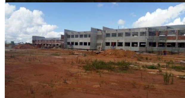
Construção da sede definitiva do Campus Palmares. Fonte: Portal IFPE
