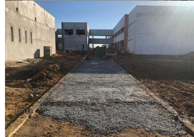
Construção da sede definitiva do Campus Igarassu. Fonte: Direção-Geral do Campus Igarassu
