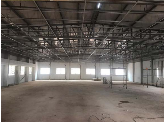
Construção da sede definitiva do Campus Jaboatão dos Guararapes. Fonte: Direção-Geral do Campus Jaboatão dos Guararapes
