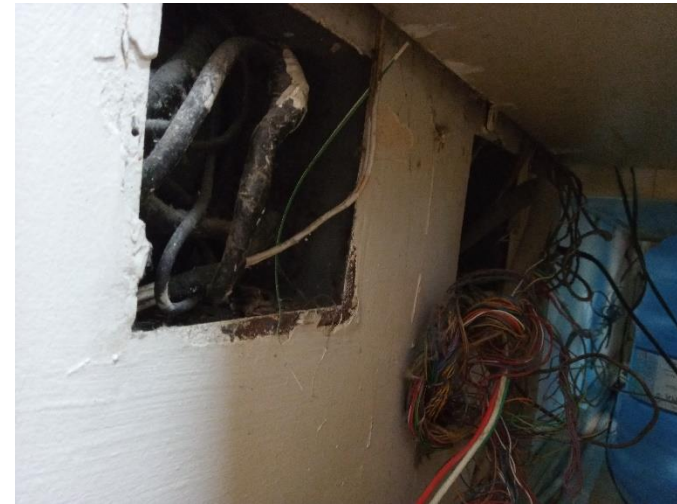
Figura 12: Caixa de disjuntores
