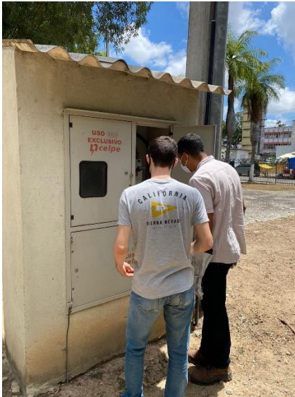
Figura 47: Parte Externa do Anexo da Sudene
