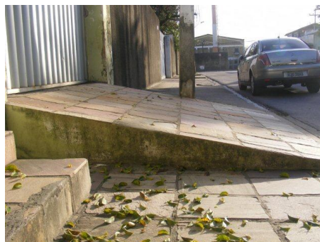
Figura 8 – Calçada do Recife –rampa obstruindo faixa livre Fonte: http://www.mobilize.org.br
